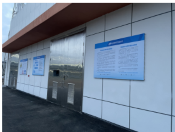
图 3-5 本项目危废暂存库
